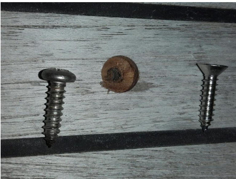
Foto 1. Hullet boret op og klar til den nye skrue til højre.
